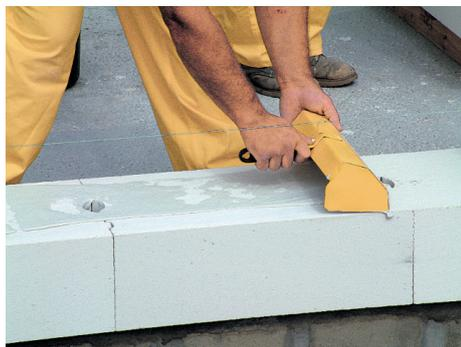
Клей TYTAN обеспечивает отличное качество сцепления, прочность и эластичность кладки. Он представляет собой уже готовый состав, а не сухую смесь.
