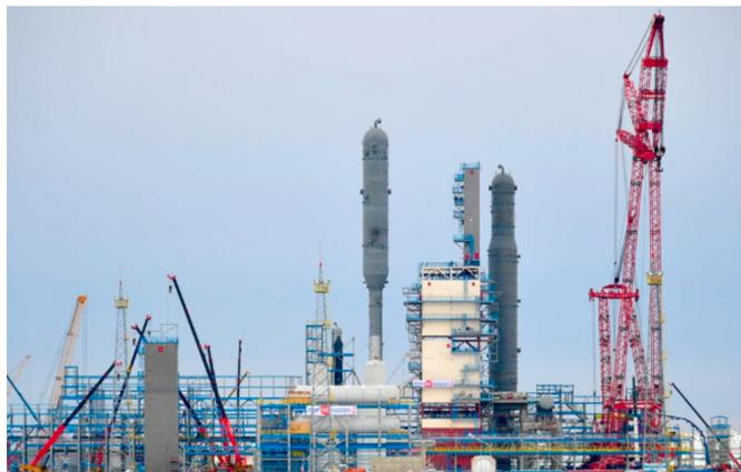
Завершен монтаж установок осушки и очистки сырьевого газа на первой и второй технологических линиях первого пускового комплекса Амурского ГПЗ. В составе каждой установки по пять адсорберов, которые позволят удалять влагу и примеси из сырьевого газа, поступающего на Амурский ГПЗ. Это важный этап технологического процесса – максимальная осушка и очистка необходимы для обеспечения эффективности дальнейшего процесса газоразделения, который осуществляется при сверхнизких температурах.
