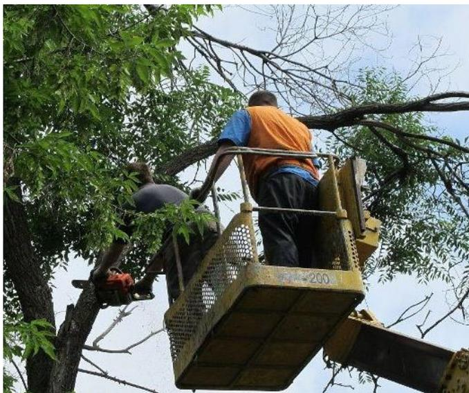
1.2. В настоящей ТТК приведены указания по организации и технологии производства работ по обрезке сучьев и деревьев бензопилой с автогидроподъемника в городской застройке, определены состав производственных операций, требования к контролю качества и приемке работ, плановая трудоемкость работ, трудовые, производственные и материальные ресурсы, мероприятия по промышленной безопасности и охране труда.
