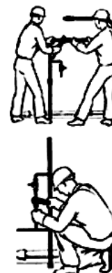
Рис. 15. Прокладка трубопроводов внутреннего водопровода на резьбе
