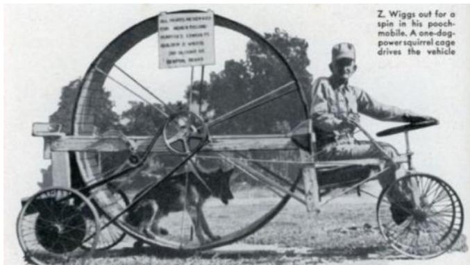
В 1939 году тренер собак из Техаса предложил революционную идею в мире автомобилестроения. Конструкция представляла собой механическую повозку с огромным колесом. Внутри него «по-хомячни» бегала собака. С помощью цепей велосипедного типа привод передавался на задние колёса. Кроме этого, была предусмотрена система переключения скоростей.
