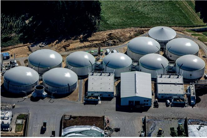
Газ поступает в систему обогрева станции, в частности в находящиеся под землей обогреватели самих метантенков: процесс сбраживания происходит при температуре +35°. Общий объем биотоплива, получаемый в течение месяца, позволяет выдавать 2,5 мегаватта мощности. Кстати, на промплощадке
