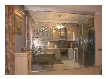
При изготовлении беспороговой перегородки учтите, что крепить направляющие можно только к бетонной плите или деревянным балкам. На подвесной потолок устанавливать такую конструкцию нельзя. Он просто не выдержит.
